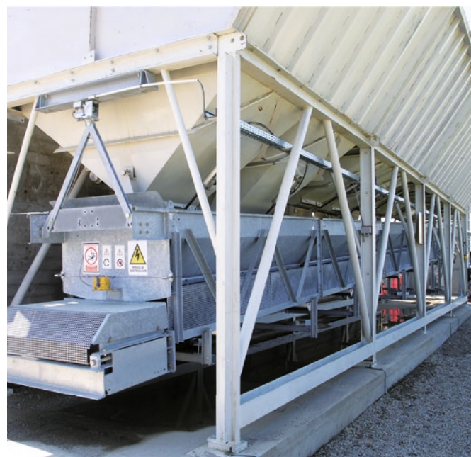
Le tapis peseur sous les trémies en ligne.
