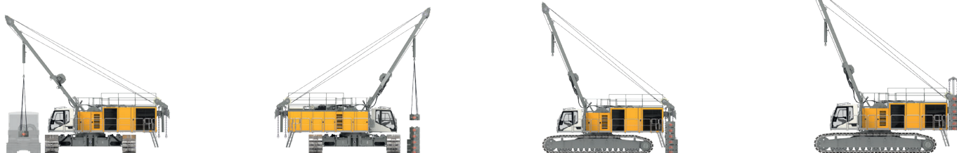
Descarga y montaje del contrapeso trasero
