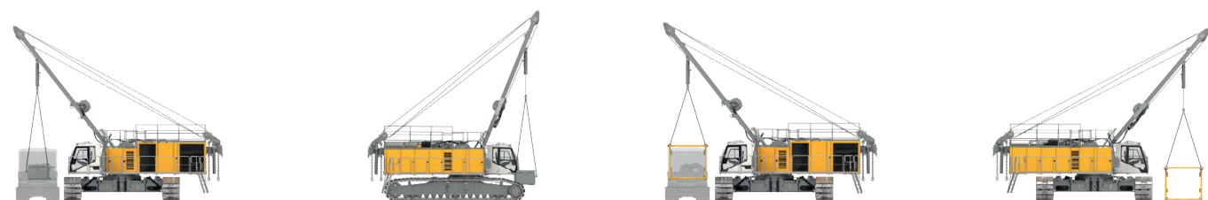
Descarga y montaje del contrapeso central
