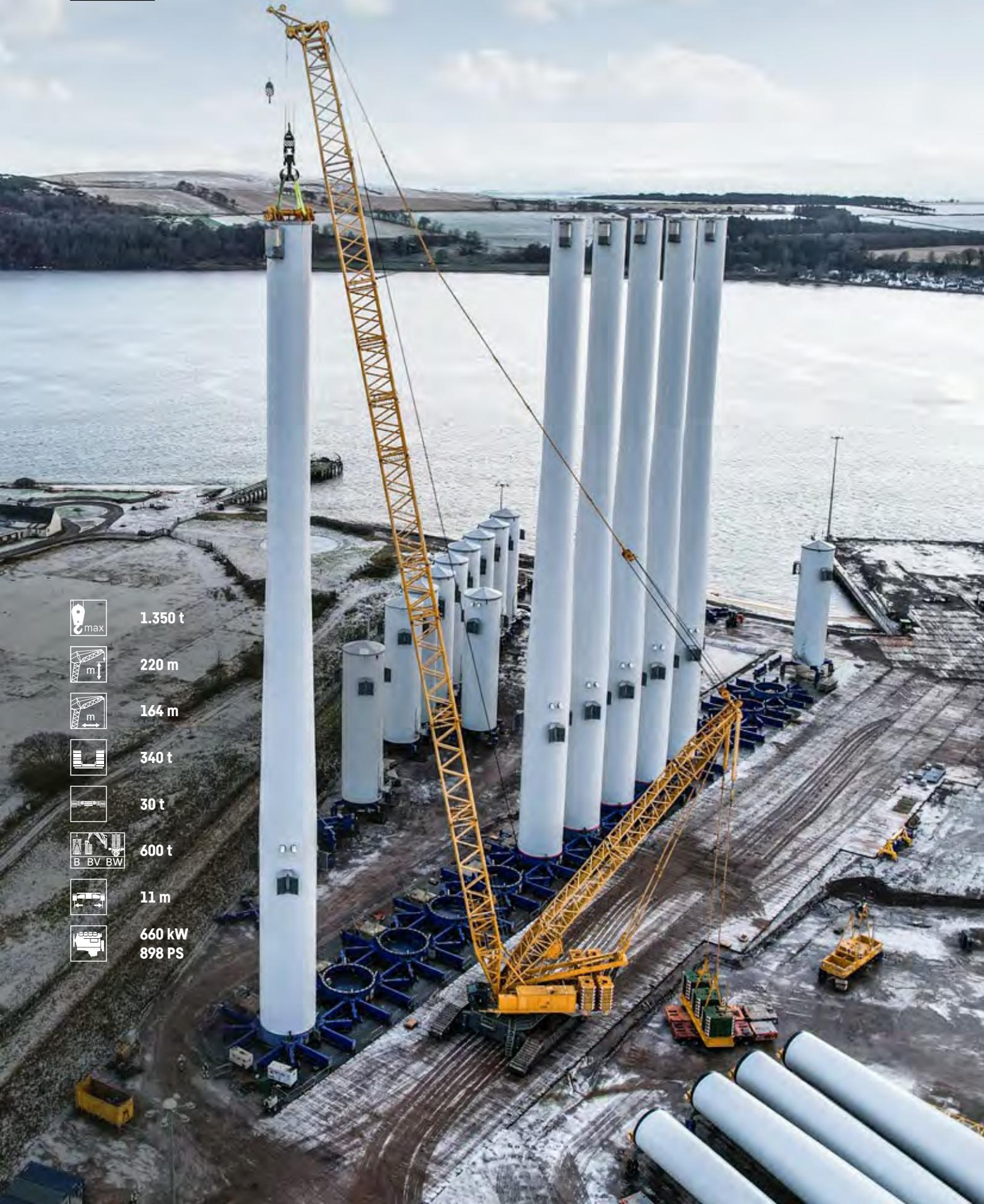
Der LR 11350 kommt mit herausragenden Tragkräften über den gesamten Arbeitsbereich zum Einsatz. Speziell im Offshore Handling ist dieser Kran universell einsetzbar, da er mit und ohne PowerBoom mit hohen Stückgewichten hantieren kann. Zudem erreicht er eine enorme Hakenhöhe von 220 Meter.
