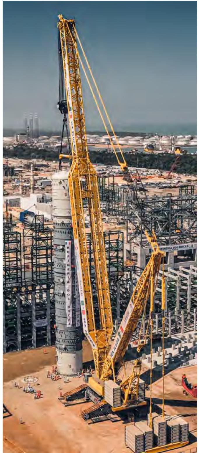
La pluma paralela PowerBoom aumenta enormemente la rigidez de la pluma, lo que permite a la LR 13000 alcanzar capacidades de elevación especialmente elevadas.
