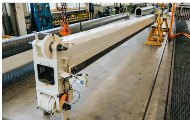
Remise en état d'une flèche télescopique
