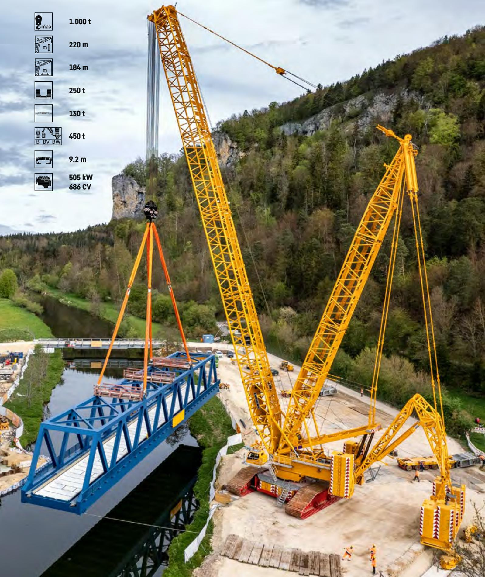
Che si tratti di infrastrutture, energia eolica, costruzioni industriali o movimentazione portuale, grazie all'ampia gamma di varianti di braccio, l'LR 11000 è ideale per ogni applicazione e convince per le eccellenti capacità di carico nell'intera gamma di lavoro. È progettata in modo ideale per un'ampia varietà di cantieri e può essere trasportata economicamente ovunque nel mondo. Una combinazione vincente di compattezza, flessibilità e resistenza.
