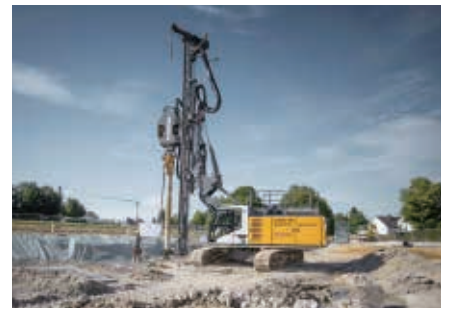
深基础施工设备
