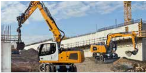
Movimiento de tierra
