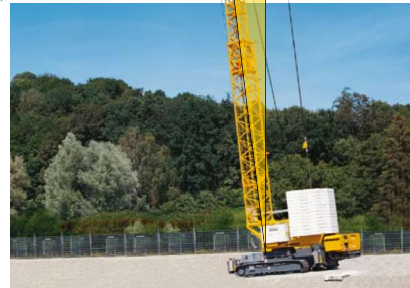
... und bis zu 10% Längs-Neigungen sind für Liebherr-Raupenkrane kein Problem.
