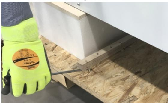
Holzleisten mit Hebeisen entfernen.
