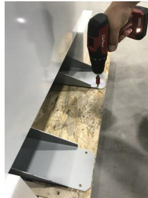
Schrauben Sie die Entladerampen ab und legen Sie sie mit den Schrauben zur Seite.
