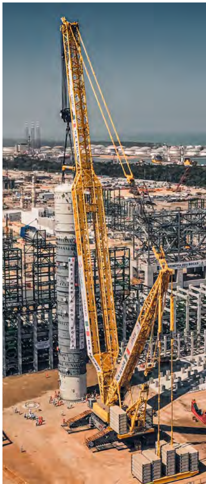
La flèche parallèle PowerBoom augmente énormément la rigidité de la flèche, ce qui permet à la LR 13000 d'atteindre des capacités de charge particulièrement élevées.
