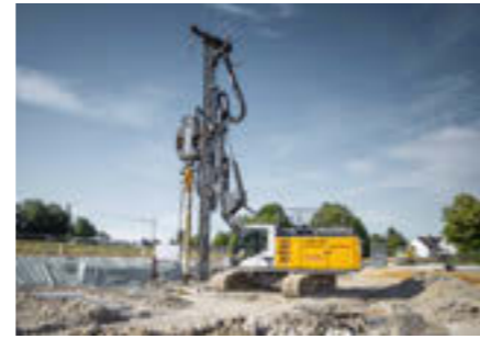
Lavori di fondazione speciali
