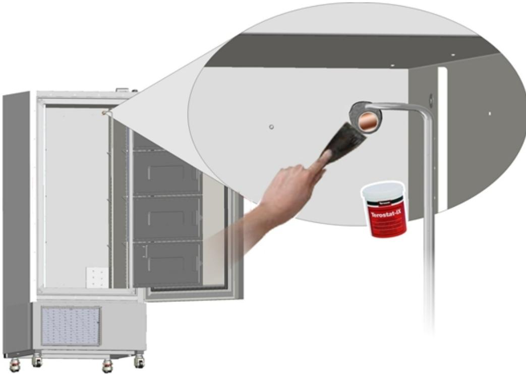
18. Schäumen Sie die Durchführung von hinten mit Zweikomponenten-PU-Schaum aus.
