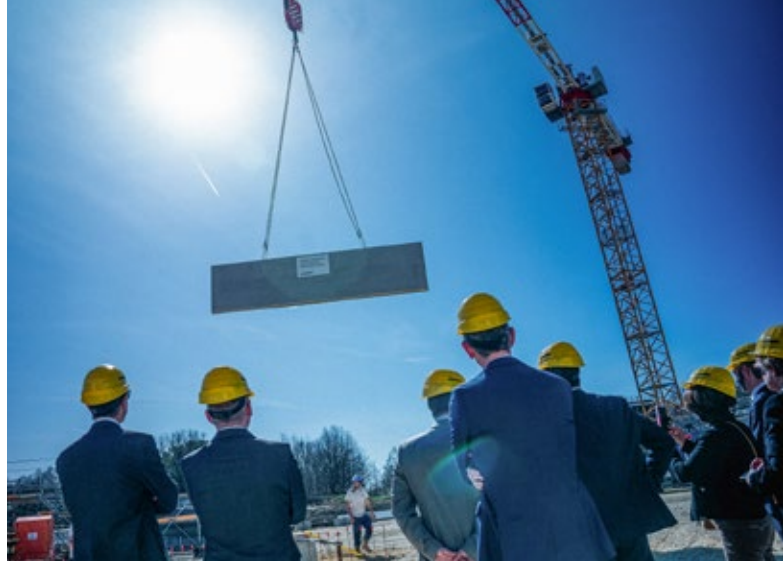
Un nouveau bâtiment de production est sorti de terre sur le site de Campsas de Liebherr-Aerospace Toulouse, dans le Tarn-et-Garonne (France).
