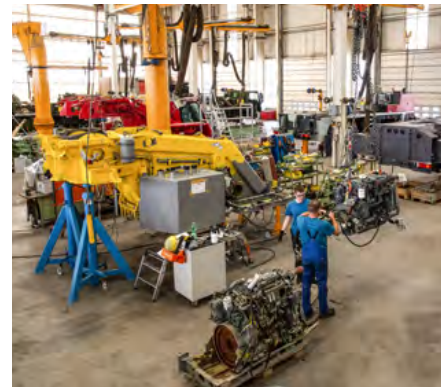
Austausch des Oberwagenmotors und Instandsetzung der Drehbühne
