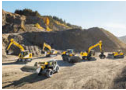
Machines de terrassement
