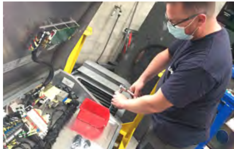
Reparaturarbeit an einem Klimagerät
