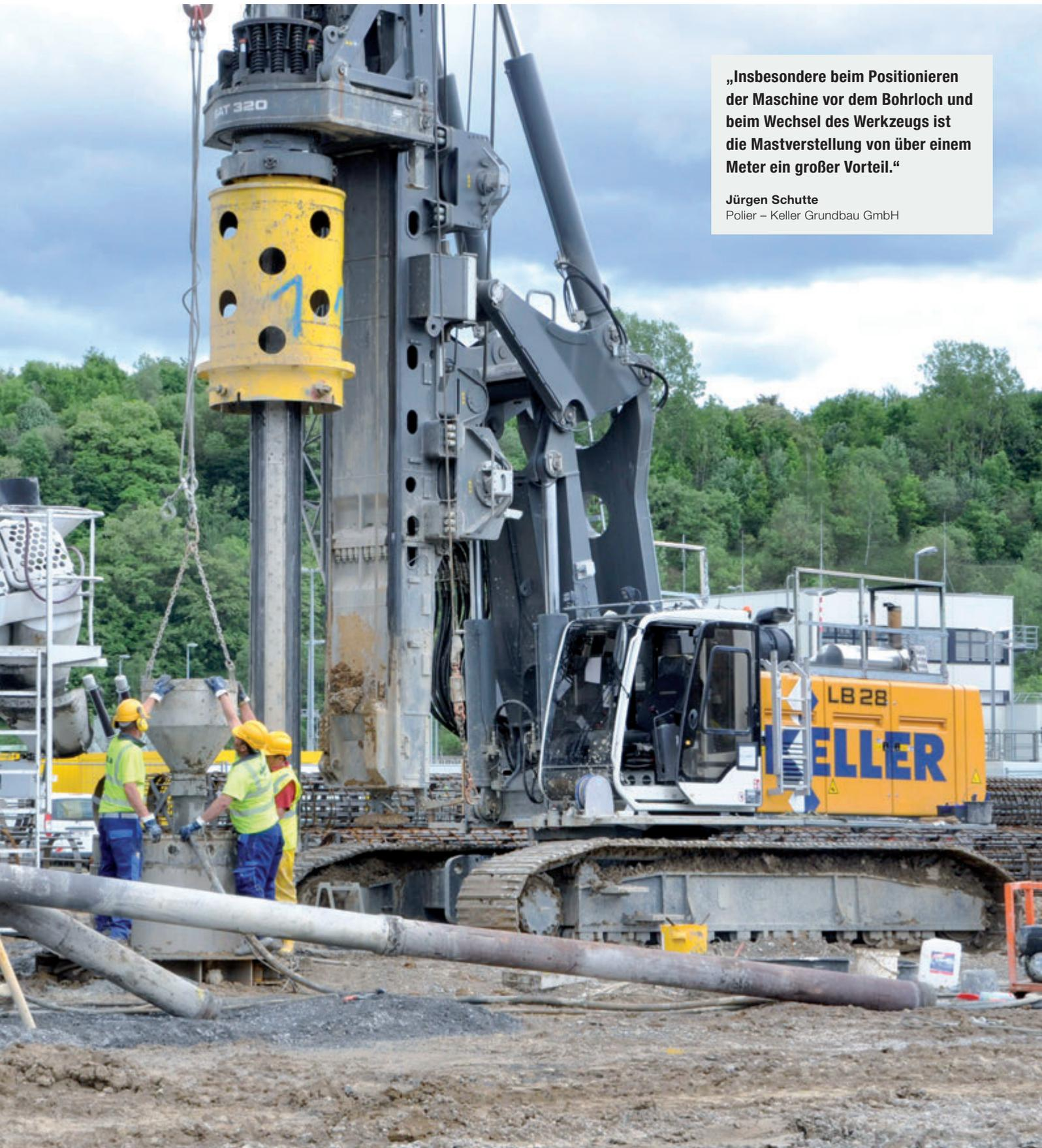
„Insbesondere beim Positionieren der Maschine vor dem Bohrloch und beim Wechsel des Werkzeugs ist die Mastverstellung von über einem Meter ein großer Vorteil.“
