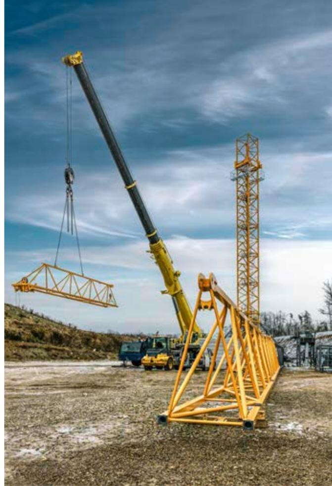
Der Ausleger kann vollständig am Boden vormontiert werden.
