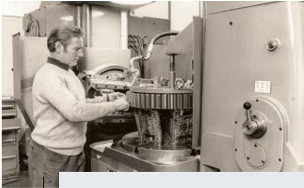
La demande en grues augmente rapidement et les couronnements d'engrenage manquent. Cela incite Hans Liebherr à ouvrir un nouveau secteur d'activité en développant une machine à tailler les engrenages.
