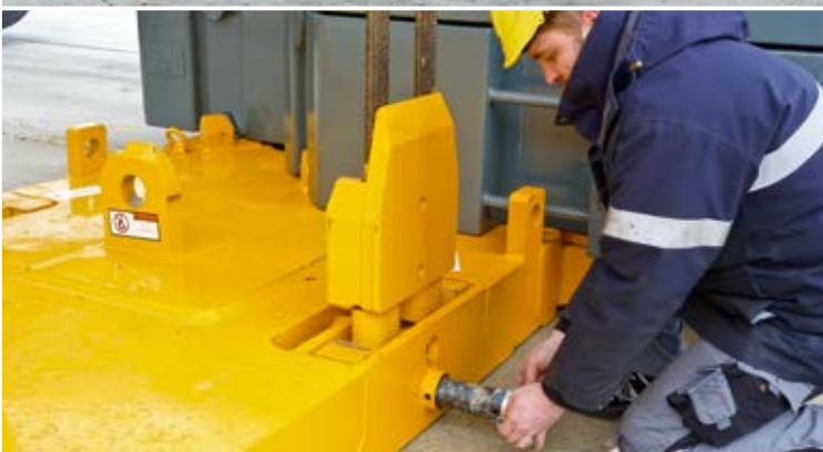
Fissaggio semplice delle piastre base con dispositivo di zavorramento
