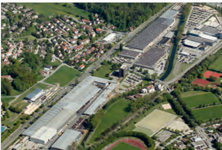
Biberach / Riß (Deutschland): Großwälzlager, Getriebe, Seilwinden, Schaltanlagen, Elektronik, elektrische Maschinen
