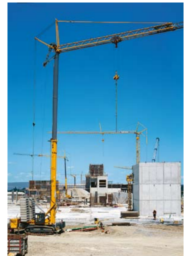
Cambio rápido de lugar: Traslación en obras de gran magnitud.
