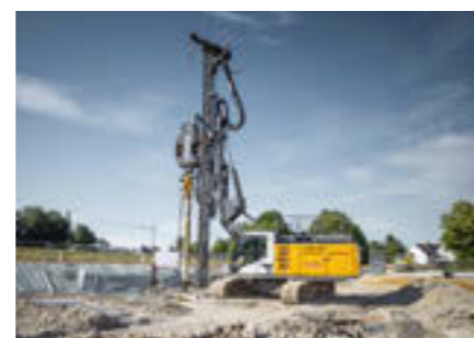
Lavori di fondazione speciali
