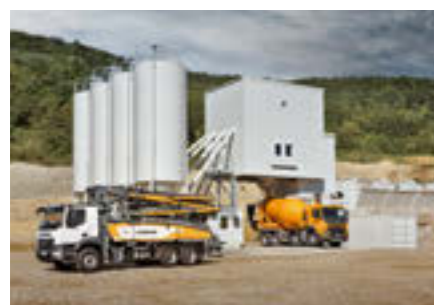
Tecnica di betonaggio
