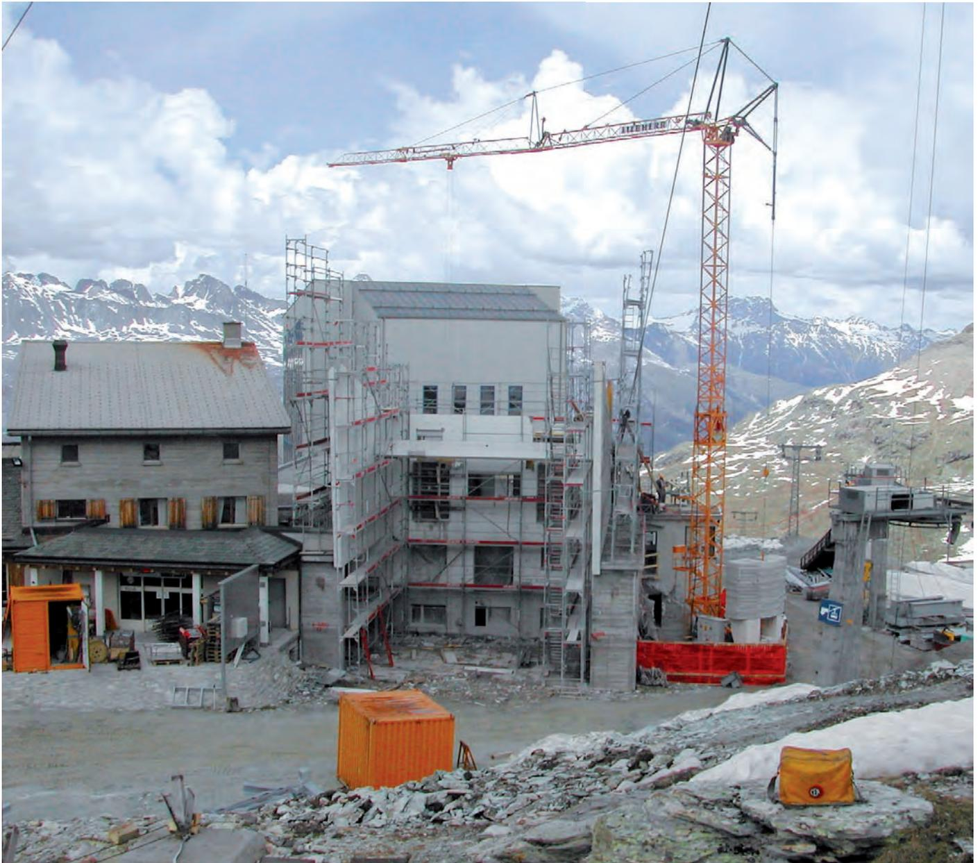
In über 2.700 m wurde im Zuge des Ausbaus der Mittelstation Murtèl am Piz Corvatsch, durch die Bauunternehmung Nicol. Hartmann & Cie. AG, der Liebherr-Schnelleinsatzkran 34 K eingesetzt.
