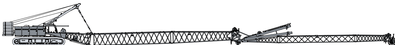
Montaje de la pluma
